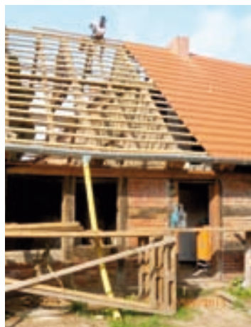
Wiederaufbau des Daches
