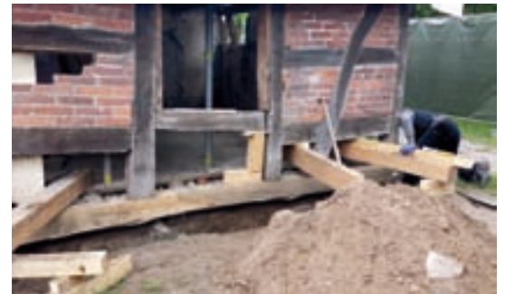
Austausch des Fußrahms und Anheben der Ecke
