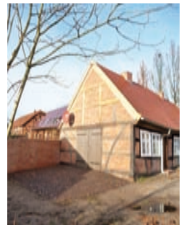
Giebel nach Fertigstellung
