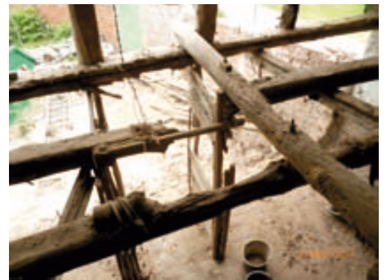
Blick ins Innere während der Sanierung
