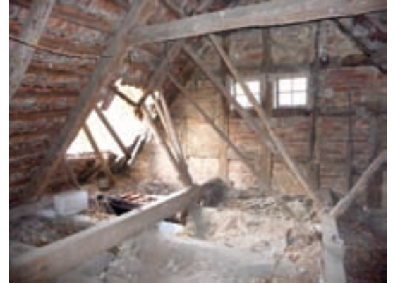
Zustand 2009 während der Notsicherung
