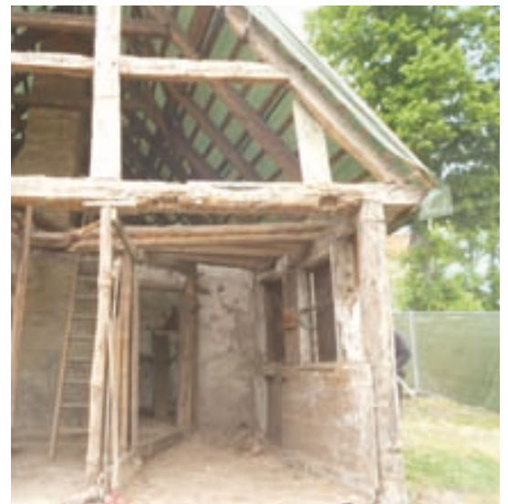
Blick ins Innere während der Sanierung
