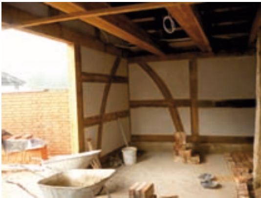
Aufbau des neuen Ziegelbodens
