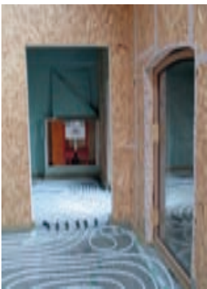
Fußbodenheizung
