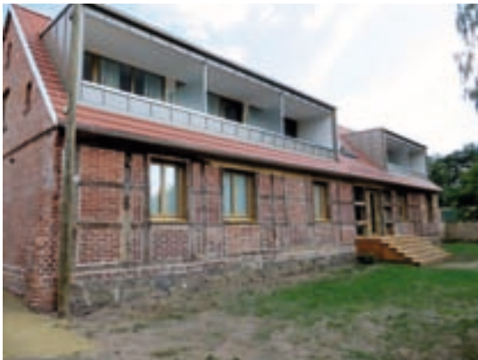
Wohnhaus Richtung Dorf
